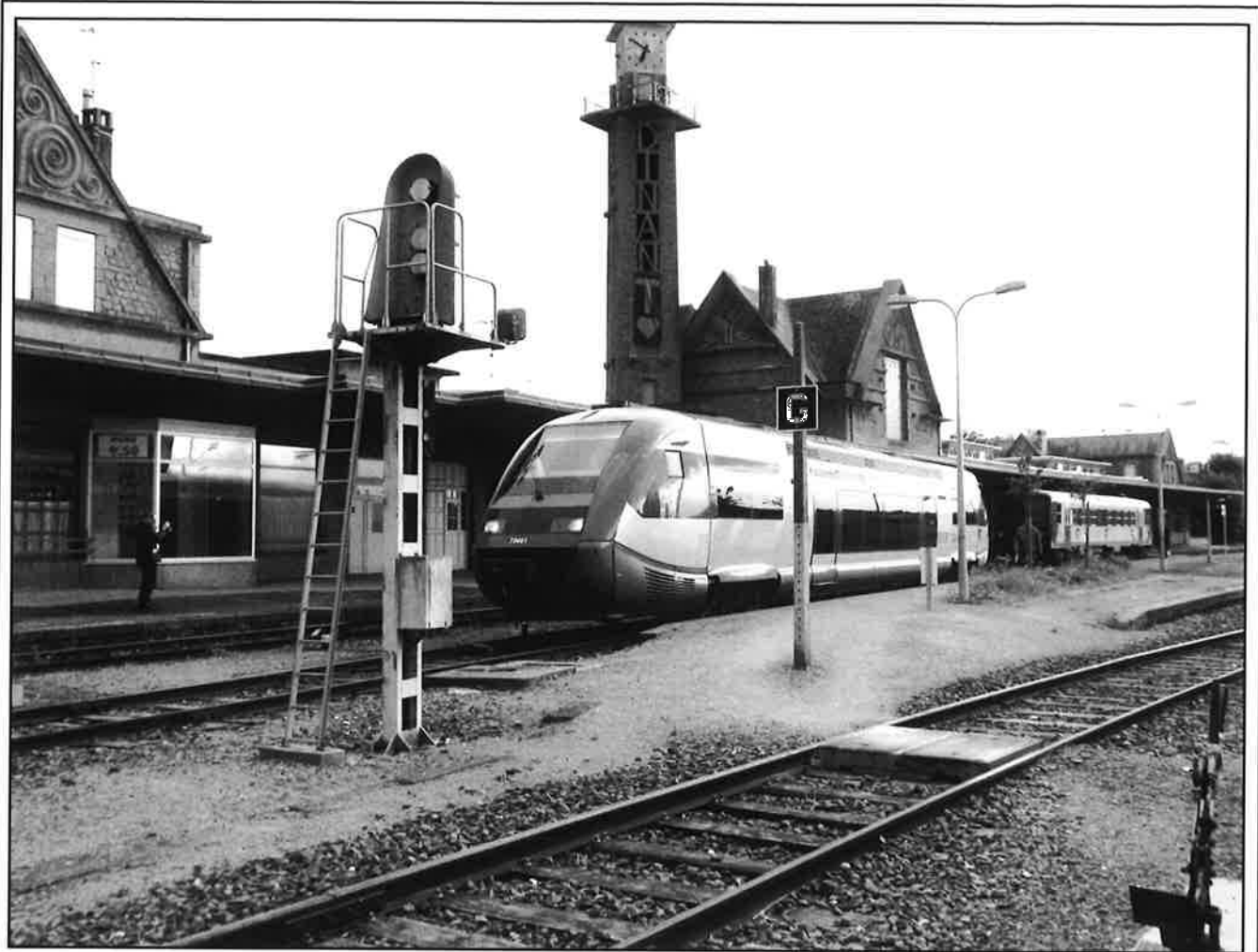
Vue de la gare de Dinan côté voies. Elle a été construite en 1936. A l'arrêt, devant le signal, l'autorail TER n°73601. (photo Jean-Claude Botspoel).
